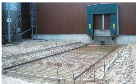
Sbancamento e preparazione per pavimentazione
